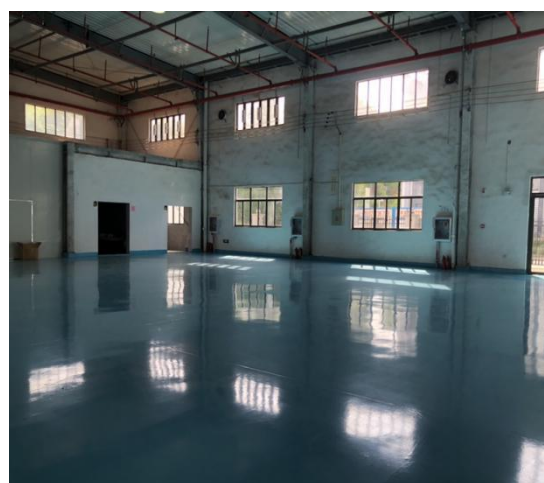
车间地面防渗
