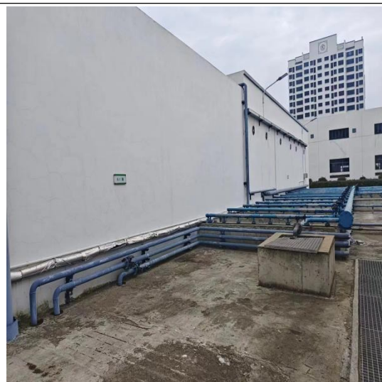
污水处理站加盖
