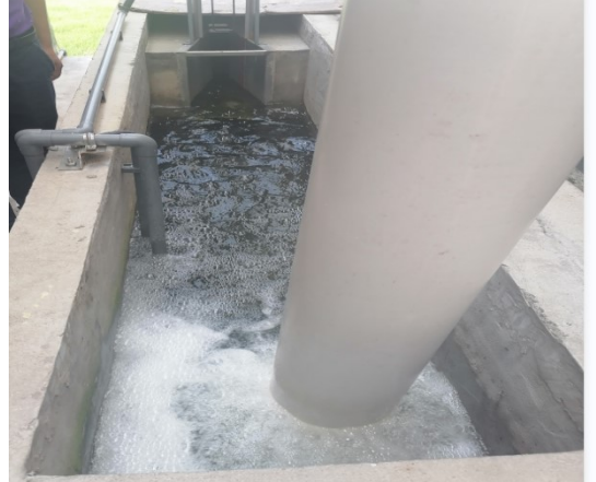
污水处理站出水口
