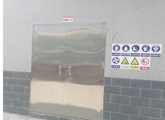
危险废物暂存间
