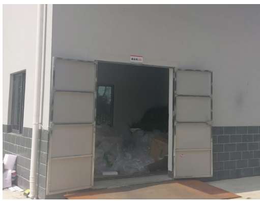
一般固废暂存间
