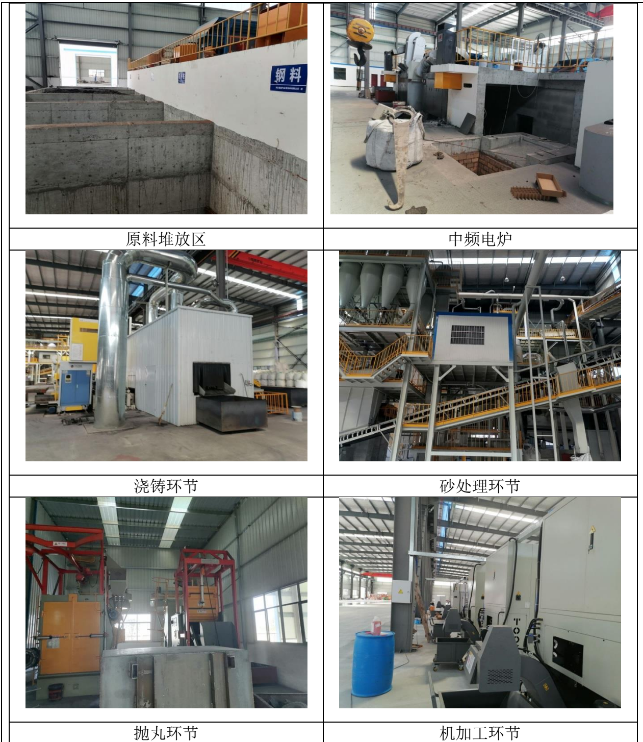
图 2-1 项目现场情况图片
